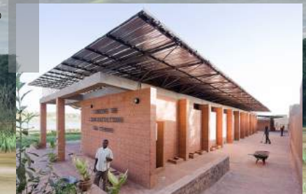
Escola Primária em Gando Kéré Architecture.
