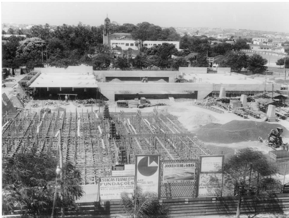
FIGURA 12 – fotografia do Jockey Clube em Obras
