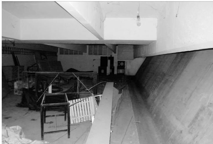
FIGURA 22 – interior do vestiário masculino, após cobertura metálica externa que encobriu a claraboia.
