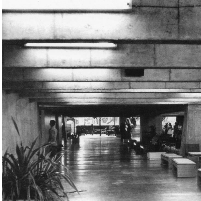
FIGURA 4 – Corredor de entrada do Jôquei Clube, sob a piscina infantil
