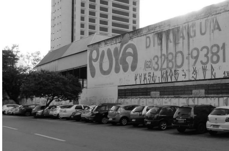
FIGURA 21 – fachada da Rua 3. Notar cobertura metálica anexa.
