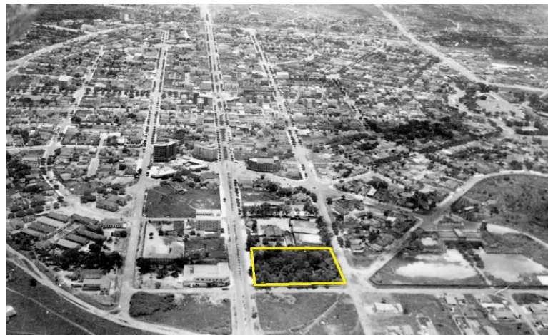
FIGURA 49 – fotografia aérea com a demarcação da área vegetal desmatada na quadra do Jóquei Clube
