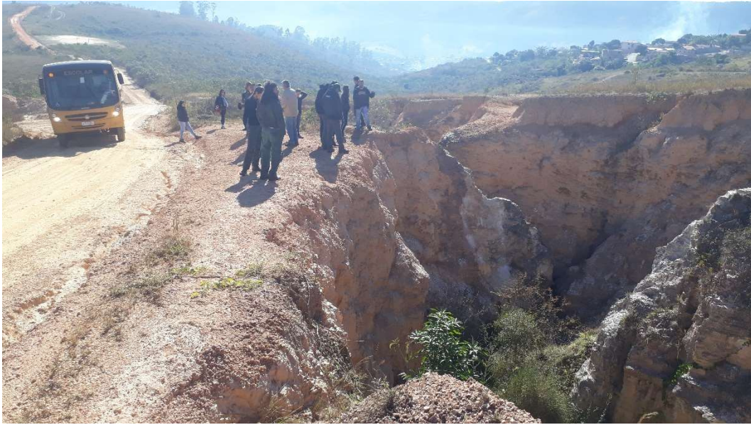
Visita aos problemas do parque, como estradas que não levaram em consideração a drenagem de águas pluviais provocando voçorocas.
