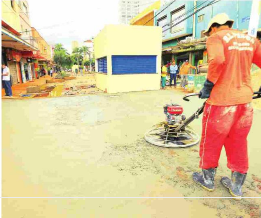
Servidores da Prefeitura de Goiânia trabalham na parte final da obra de revitalização da Rua do Lazer
