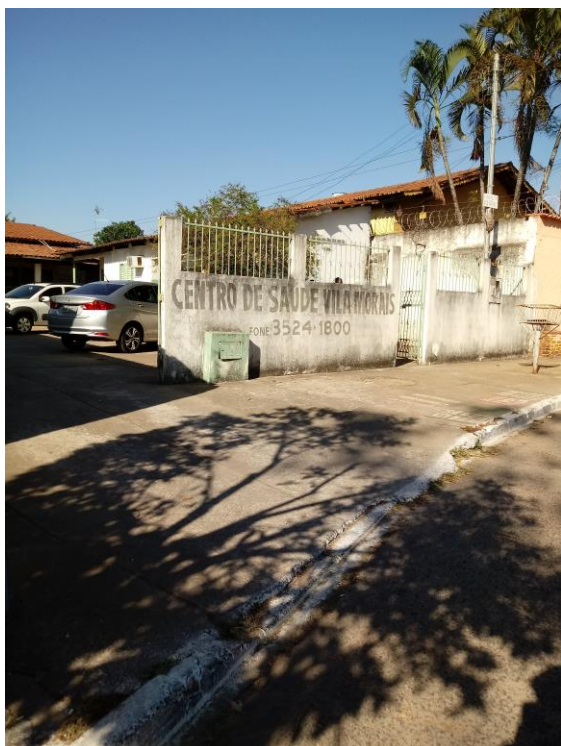
IMAGEM 03 – Calçada da rua de acesso à edificação Fonte: João Gonzaga 09/07/2018.
