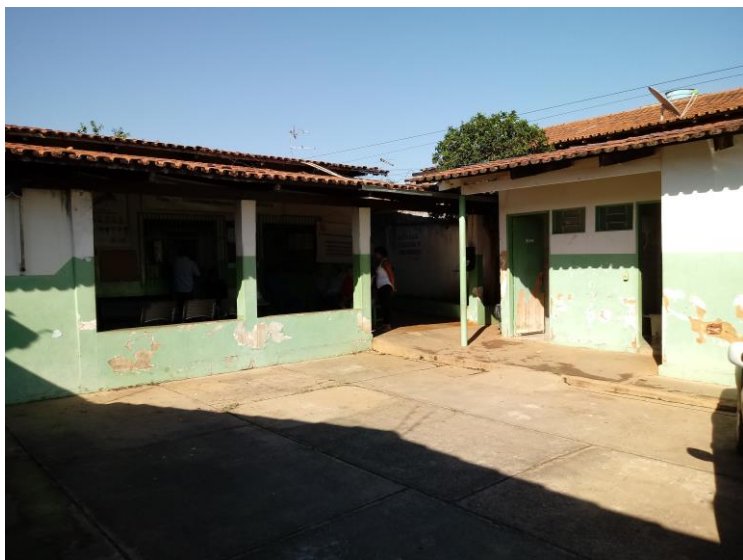
IMAGEM 02 – Vista do estacionamento. Fonte: João Gonzaga 09/07/2018.
