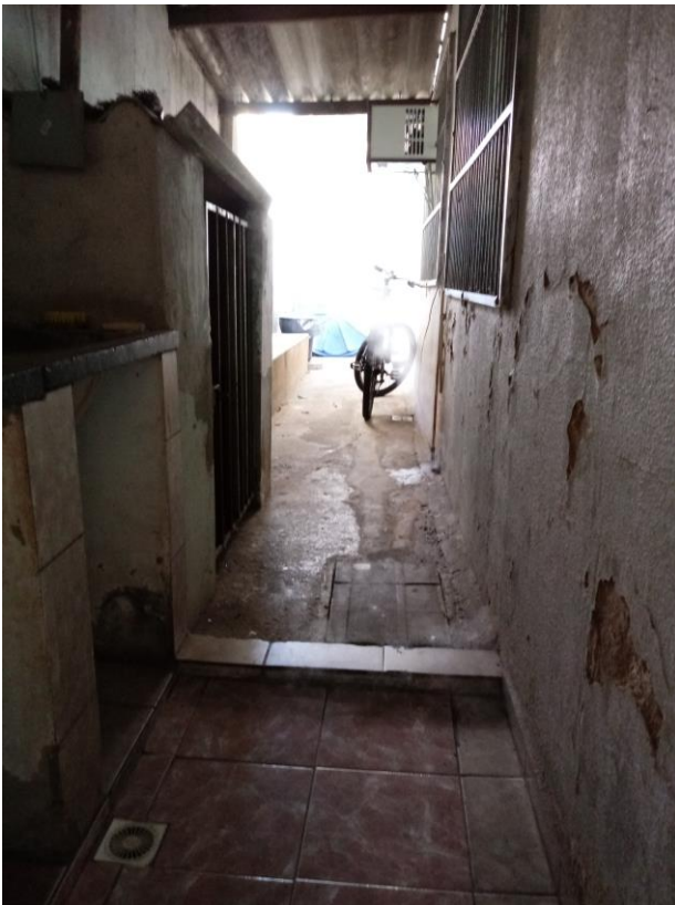
IMAGEM 26 – Acesso de funcionários. Fonte: João Gonzaga 09/07/2018.
