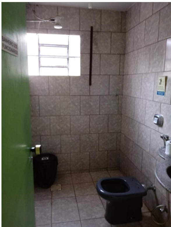
IMAGEM 22 – Sanitário de funcionários. Fonte: João Gonzaga 09/07/2018.
