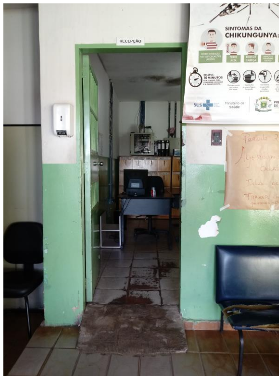
IMAGEM 17 – Acesso consultórios. Fonte: João Gonzaga 09/07/2018.
