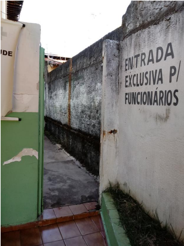
IMAGEM 24 – Acesso de funcionários. Fonte: João Gonzaga 09/07/2018.
