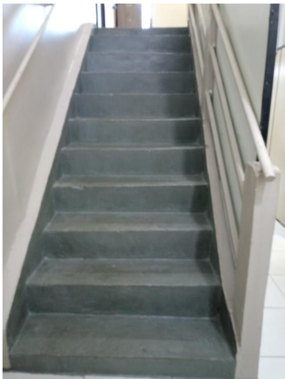
IMAGEM 21 – Acesso ao segundo pavimento. Fonte: João Gonzaga 19/06/2018.
