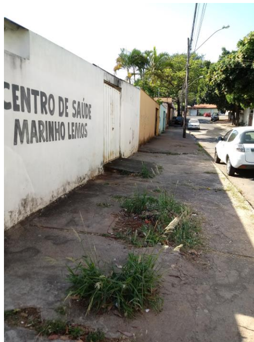
IMAGEM 25 – Calçada lateral danificada. Fonte: João Gonzaga 14/08/2018.
