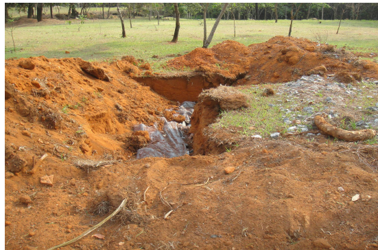
Figura 13 – Obras das valas de infiltração no Parque Flamboyant Fonte: Isabel Pastore, setembro de 2012.
