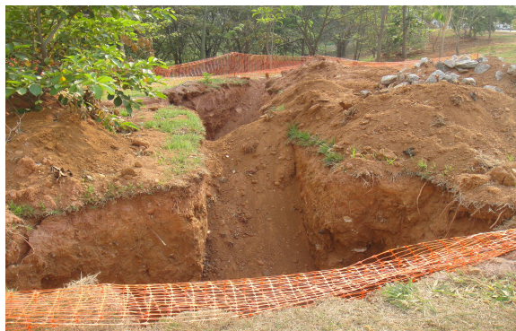
Figura 12 – Obras das valas de infiltração no Parque Flamboyant Fonte: Isabel Pastore, setembro de 2012.
