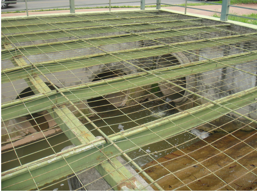
Figura 15 – Canalização da água que sai do lago. Fonte: Isabel Pastore, setembro de 2012.
