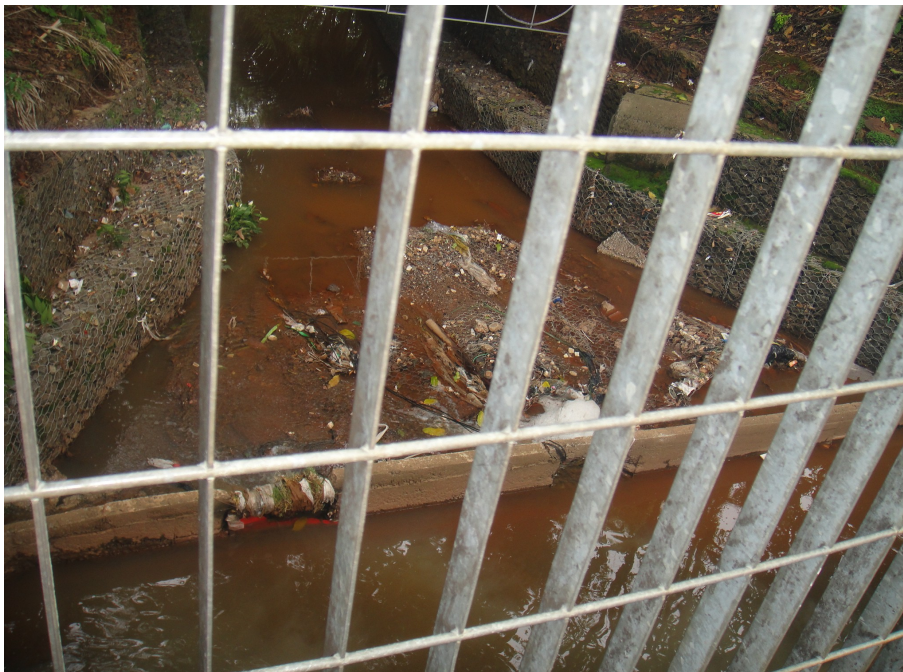
Figura 16 – Retorno da água canalizada ao córrego. Fonte: Isabel Pastore, setembro de 2012.
