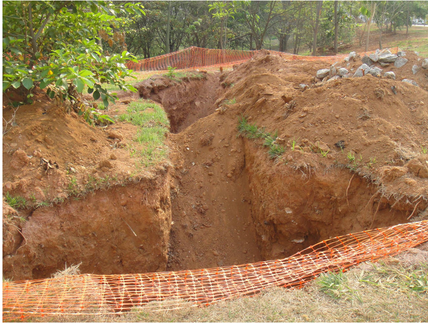
Figura 19 – Obras da vala de infiltração. Fonte: Isabel Pastore, setembro de 2012.
