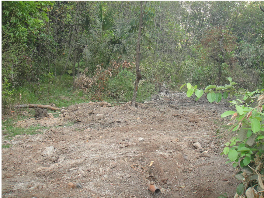
Figura 20 – Aterramento das áreas revegetadas no entorno da nascente. Fonte: Isabel Pastore, setembro de 2012.
