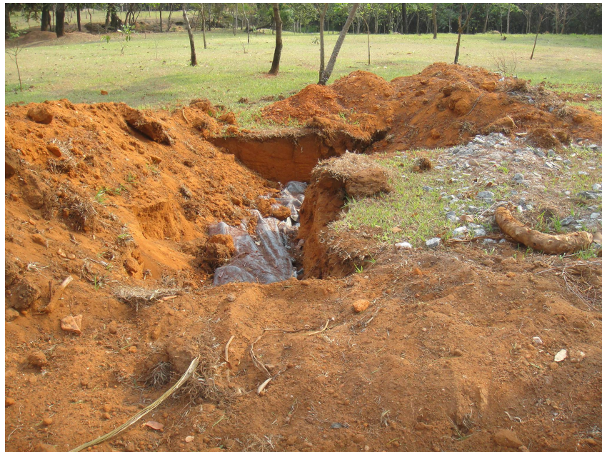
Figura 18 – Obras da vala de infiltração. Fonte: Isabel Pastore, setembro de 2012.
