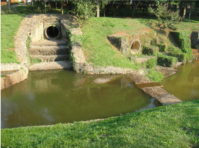
Figura 12 – Estrutura de condução de água pluvial.
