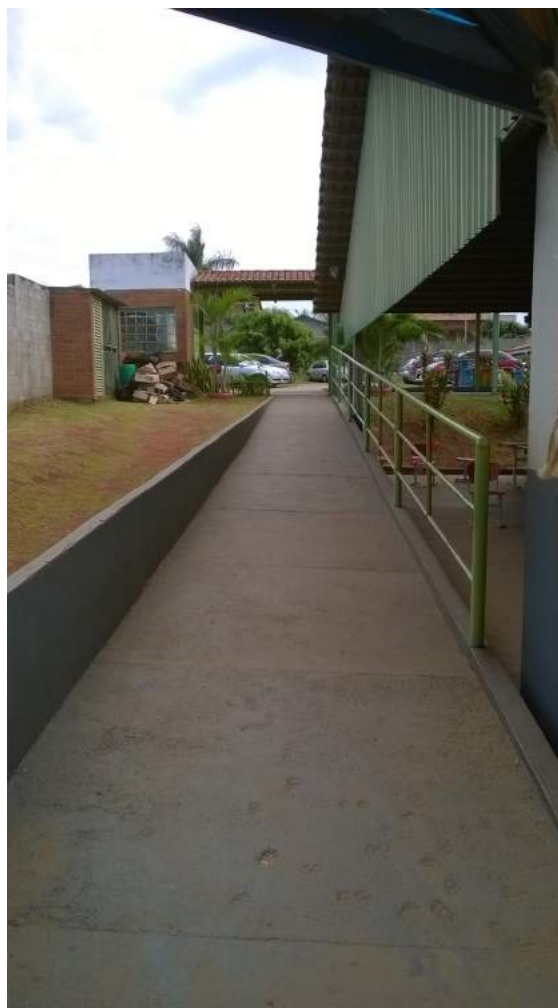
IMAGEM 09 – Rampa de acesso ao refeitório e quadra esportiva Fonte: Analista Fiscal
