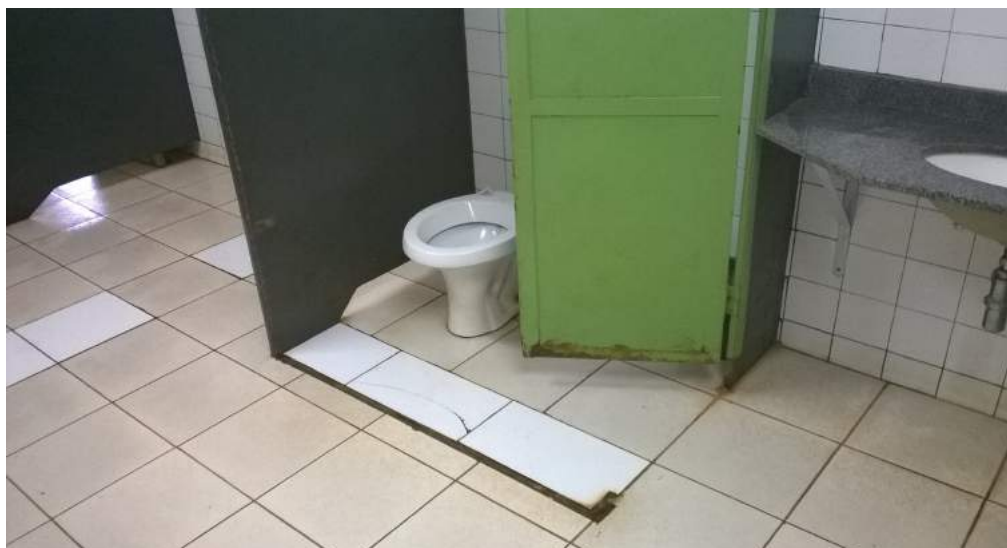
IMAGEM 012 – Instalação das divisórias em ardósia Fonte: Analista Fiscal
