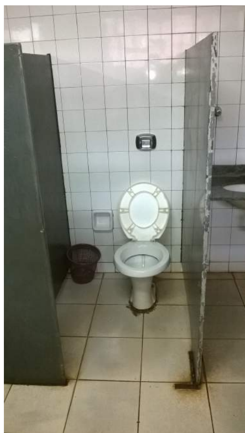
IMAGEM 013 – Instalação das divisórias em ardósia Fonte: Analista Fiscal
