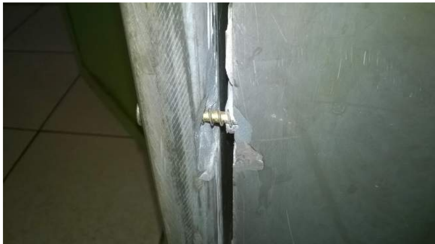
IMAGEM 015 – Instalação das divisórias em ardósia Fonte: Analista Fiscal
