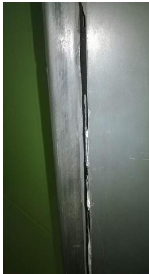
IMAGEM 014 – Instalação das divisórias em ardósia Fonte: Analista Fiscal
