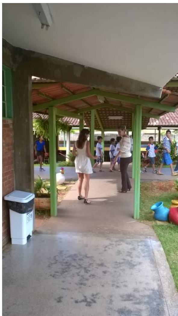
IMAGEM 06 – Rampa de acesso ao banheiro acessível Fonte: Analista Fisca
