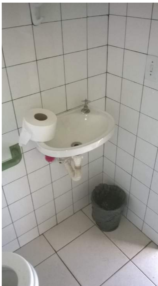
IMAGEM 04 – Lavatório do banheiro acessível Fonte: Analista Fiscal
