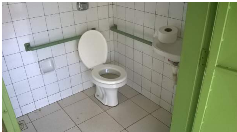
IMAGEM 03 – Bacia sanitária e barras de apoio do banheiro acessível Fonte: Analista Fiscal
