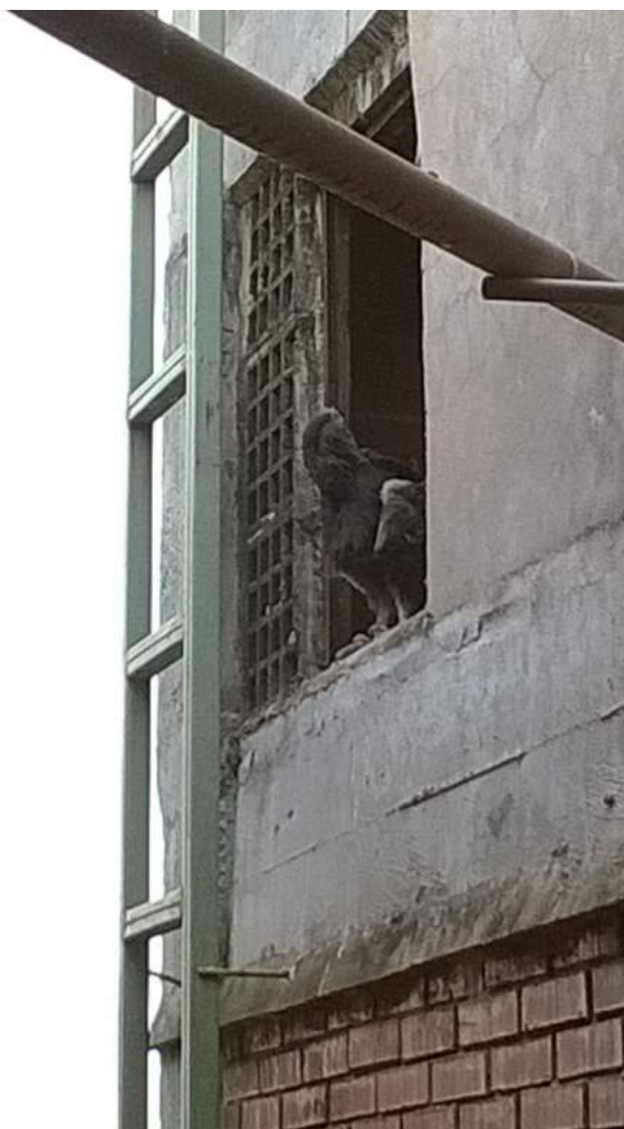
IMAGEM 023 – Acesso à caixa d'água Fonte: Analista Fiscal
